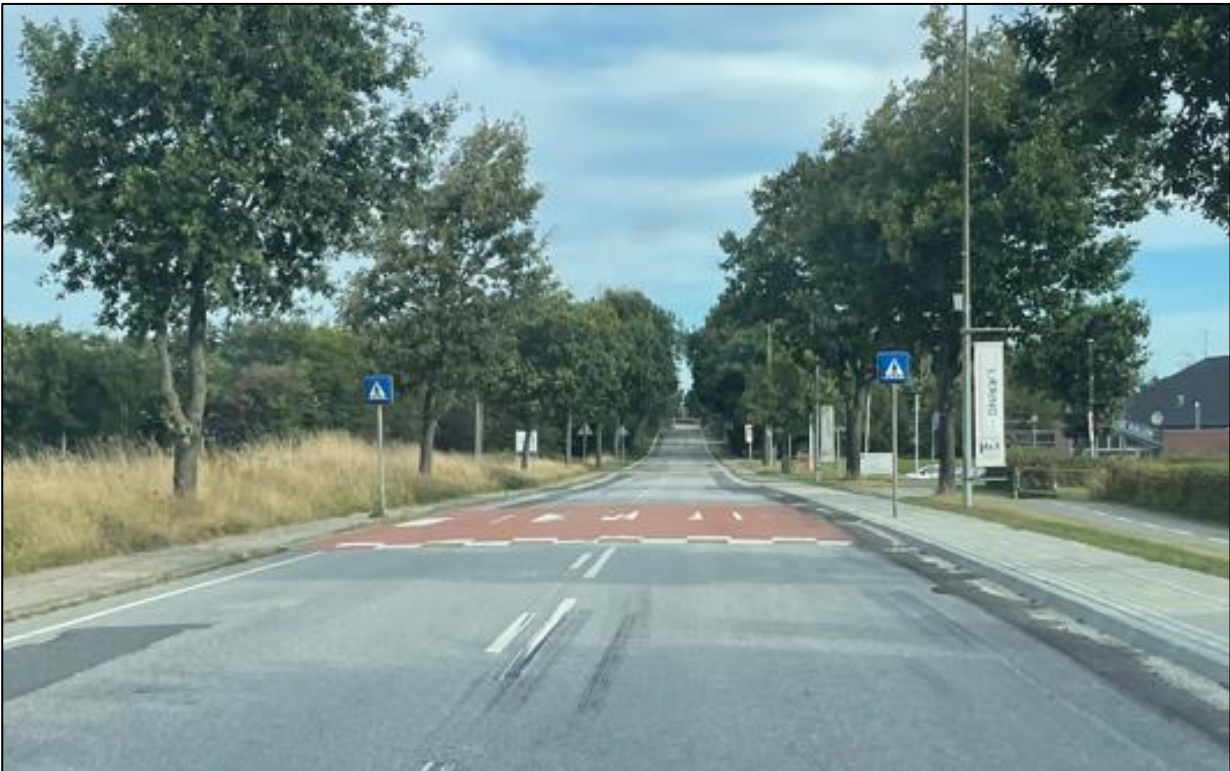
Figur 10. Hævet flade med fodgængerfelt ud for Vorgod-Barde skole, set mod nord.
